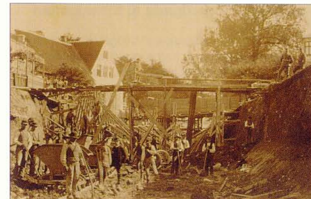
Fæstningskanalen under udgravning ved Lyngby Hovedgade 1887
