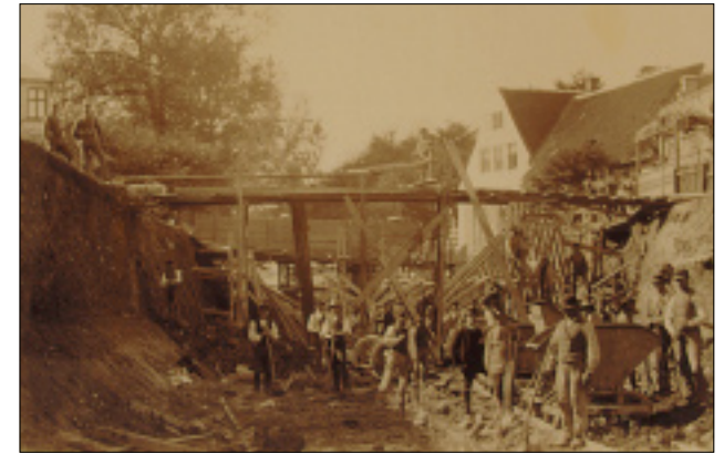
Fæstningskanalen under udgravning ved Lyngby Hovedgade 1887
